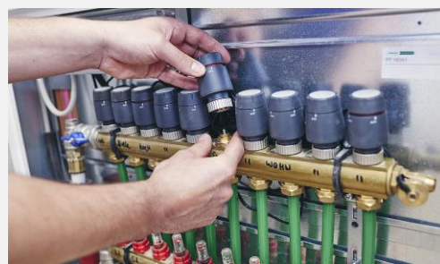
Foto: hydraulischer Abgleich, www.energie-experten.org
